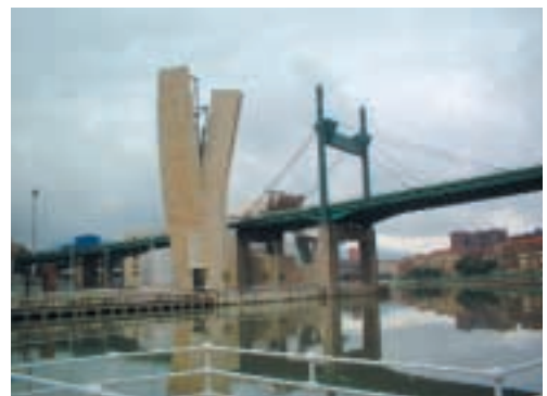
Puente de la Salve, Bilbao
